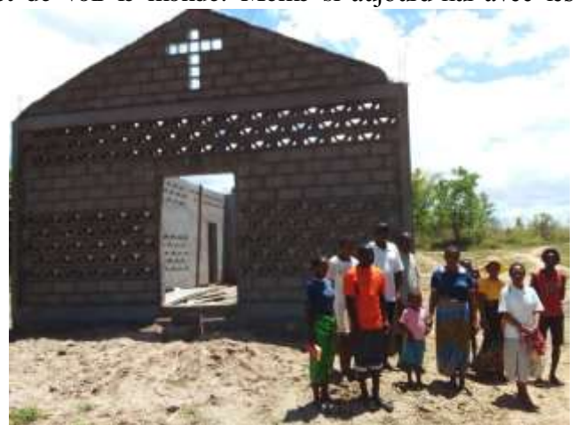
Eglise de Benavony en construction
